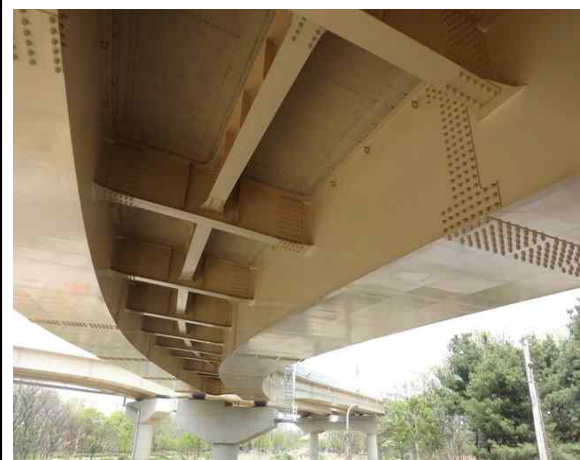
위 치 거터외부 전경 현 황 전경
