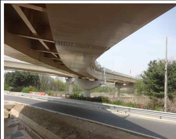
위 치 교각 현 황 전경
