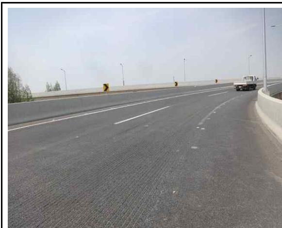
위 치 교면포장 현 황 전경
