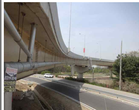
위 치 거터외부 및 배수시설 배수관 현 황 전경
